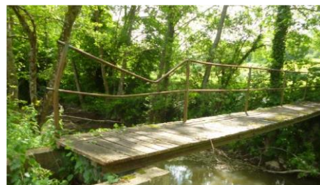
Restauration d'une passerelle. Renforcement et mise en place d'un second garde corps avant...
